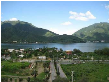
PRESA DE LA BOCA
